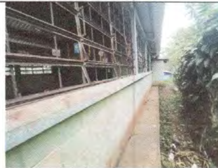
FOTO 10: Sustitución de barandas de metal.
