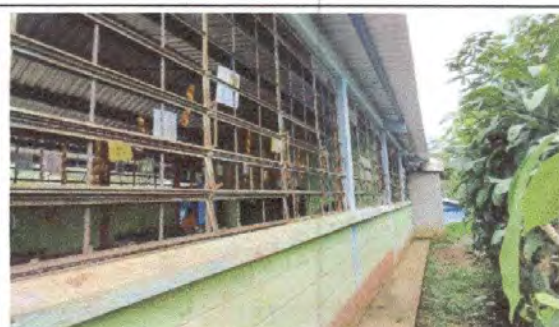
FOTO 16: Fabricación e instalación de balcones de hierro en ventana
