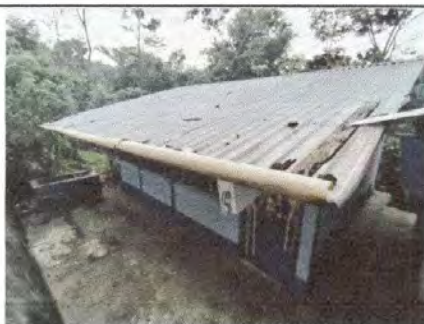
FOTO 3: Sustitución de canal de metal
