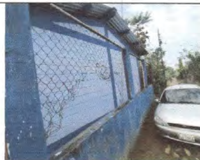
FOTO 12: Reparación de tubo hg y malla galvanizada
