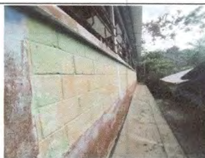
FOTO 4: Pintura en muros exteriores e interiores
