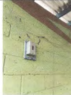
FOTO 8: Instalación de acometida eléctrica
