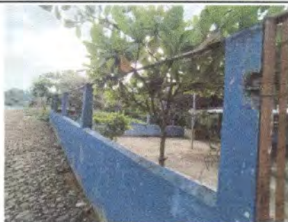
FOTO 9: Pintura en muros exteriores e interiores
