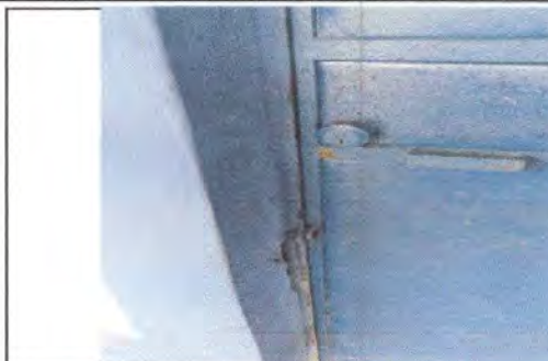
FOTO 14: Sustitución de chapa
