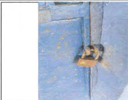
FOTO 13: Sustitución de chapa
