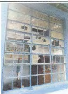
FOTO 5: Fabricación e instalación de balcones de hierro en ventana
