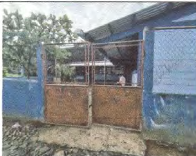
FOTO 11: Mantenimiento a portones de metal
