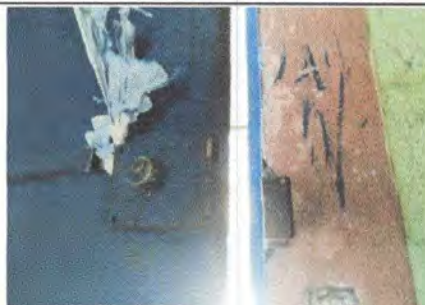
FOTO 2: Sustitución de chapa
